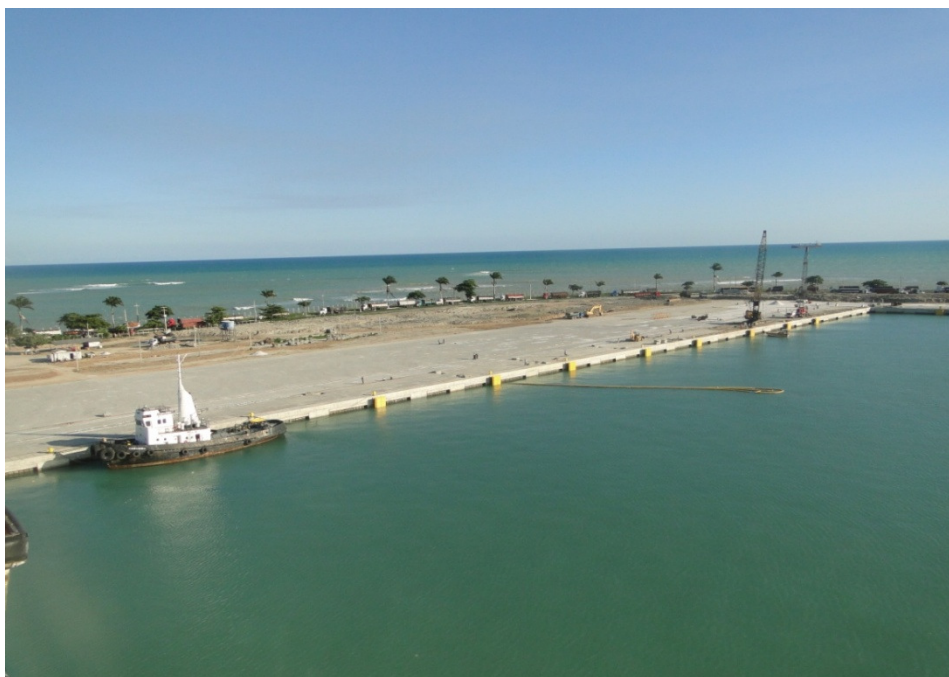
Foto 2.5 – Detalhe do Cais de Múltiplo Uso
