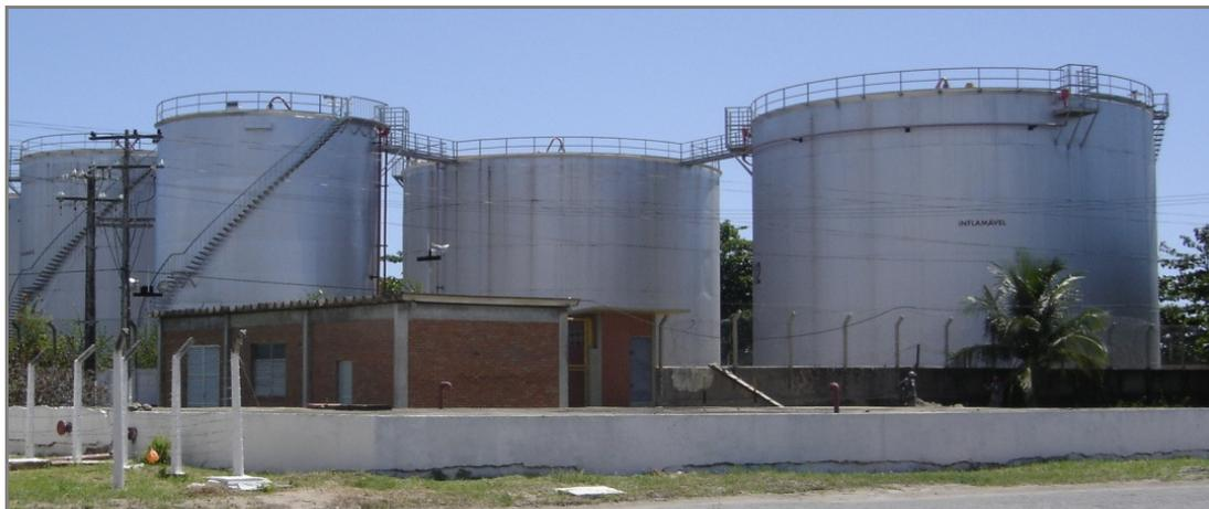
*Foto 6 – Tanques para armazenagem de derivados de petróleo*
