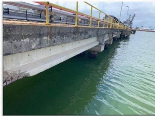
Figura 89 – Registro de Armadura Exposta no Berço 7
