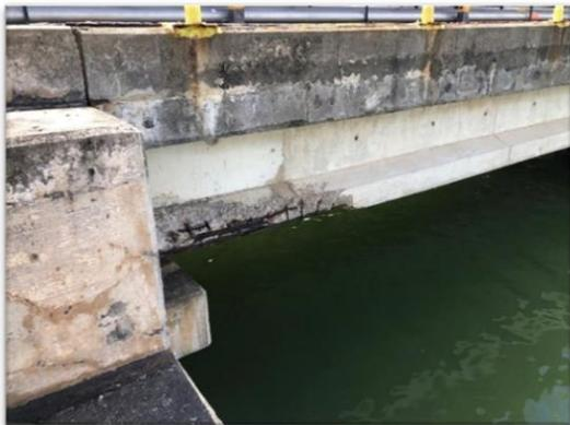
Figura 88 – Registro de Armadura Exposta no Berço 7
