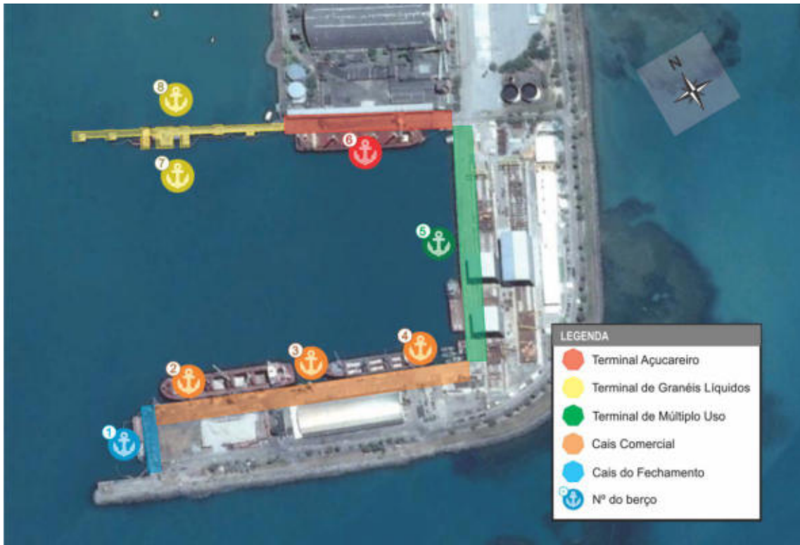
Figura 4. Infraestrutura de Acostagem do Porto de Maceió
