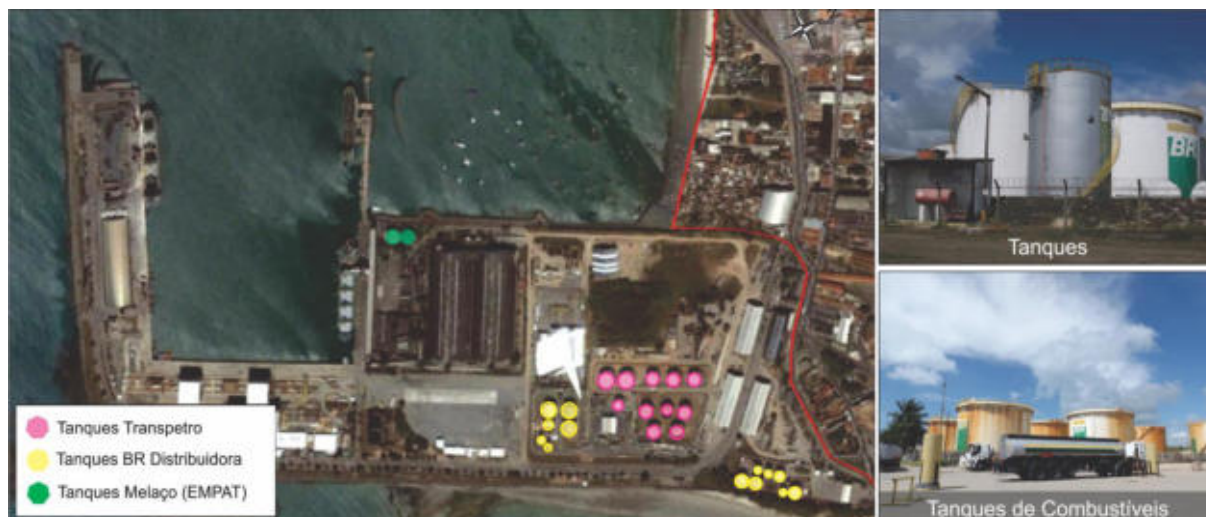
Figura 7. Tanques do Porto de Maceió
