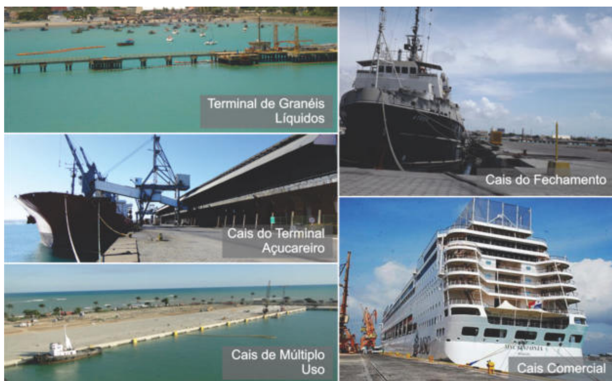
Figura 5. Trechos de Cais do Porto de Maceió
