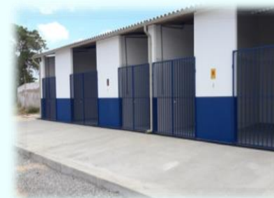
Figura 16 . Construção da ATT da GERTAB
