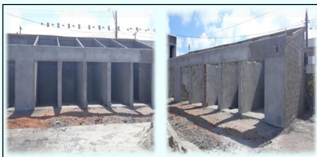
Figura 15. Construção da área de transbordo temporário de Natal.
