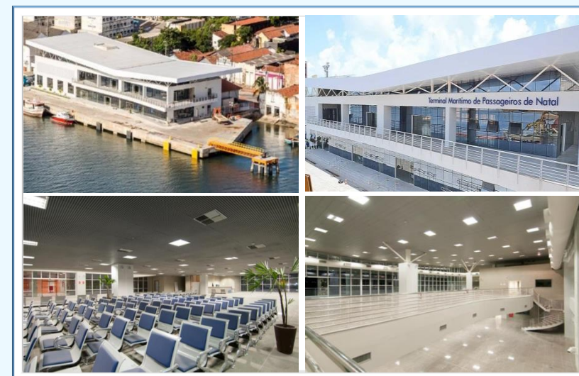
Figura 02. Estrutura do Terminal Marítimo de Passageiros - TMP FONTE: CODERN
