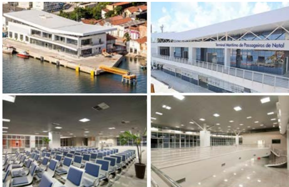
Figura 2. Estrutura Terminal Marítimo de Passageiros - TMP Fotos: CODERN
