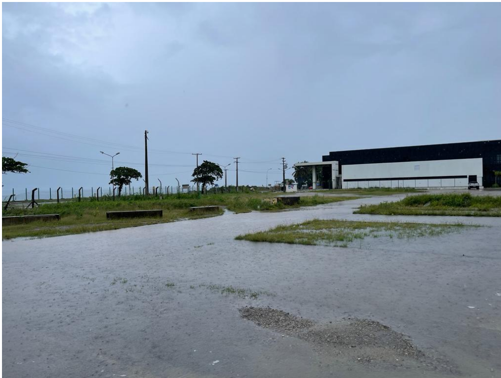
Terreno em aterro hidráulico e vegetação rasteira na superfície (lâmina de água devido as chuvas).
