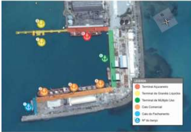
Figura 6. Infraestrutura de Acostagem do Porto de Maceió Fonte: Google Earth ([s./d.]); Elaborado por LabTrans
