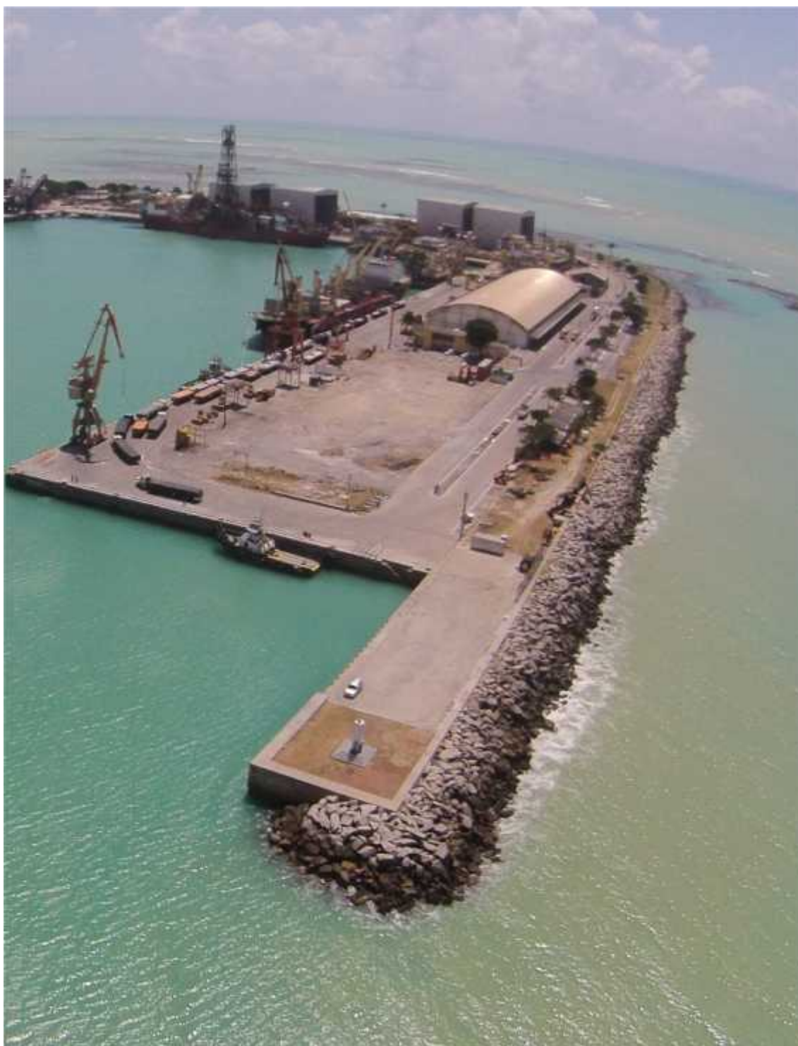
Figura 08 – CAIS COMERCIAL E CAIS DE FECHAMENTO
