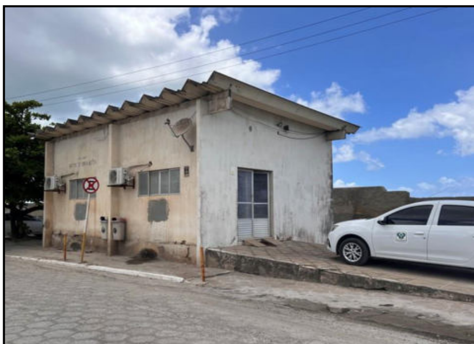
Foto 3: Prédio da TECON. Fonte: Ensima, 2022.
