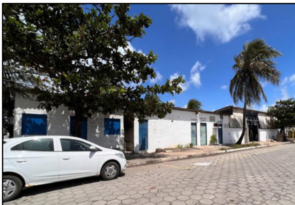
Foto 6: Prédio de manutenção dos equipamentos do porto. Fonte: Ensima, 2022.
