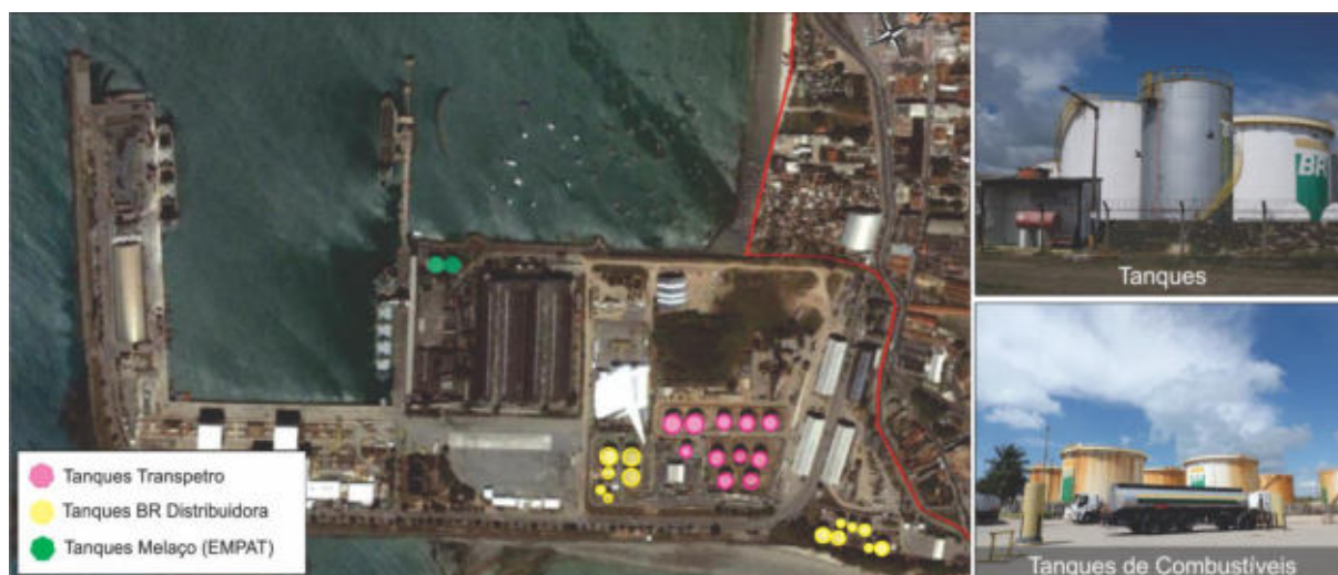
Figura 58. Tanques do Porto de Maceió
