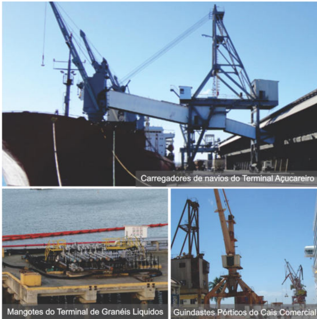
Figura 60. Equipamentos de Cais
