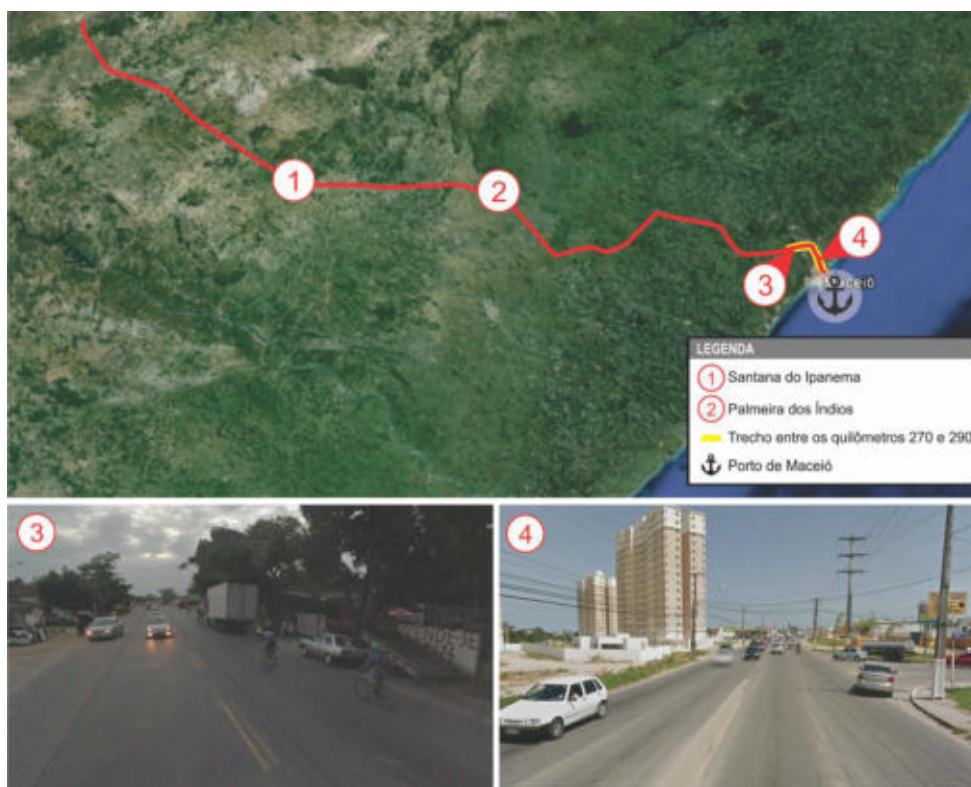
Figura 13. Pontos Críticos BR-316-AL
