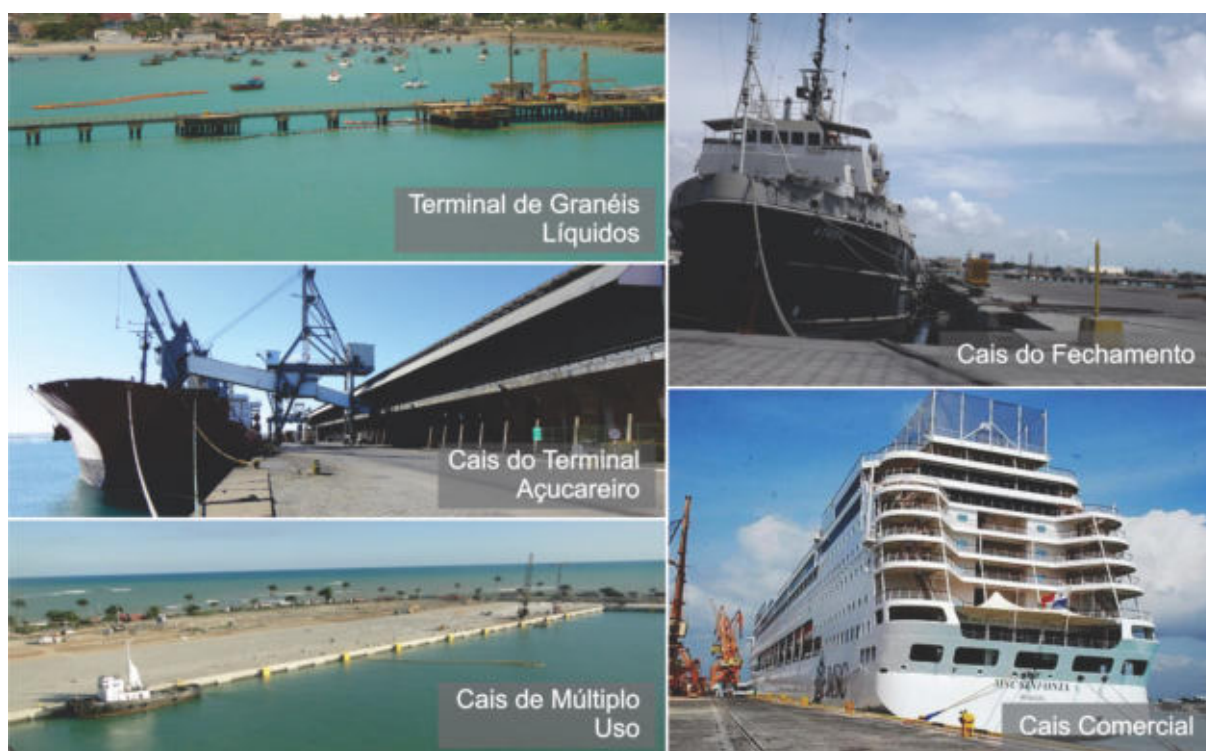
Figura 5. Trechos de Cais do Porto de Maceió
