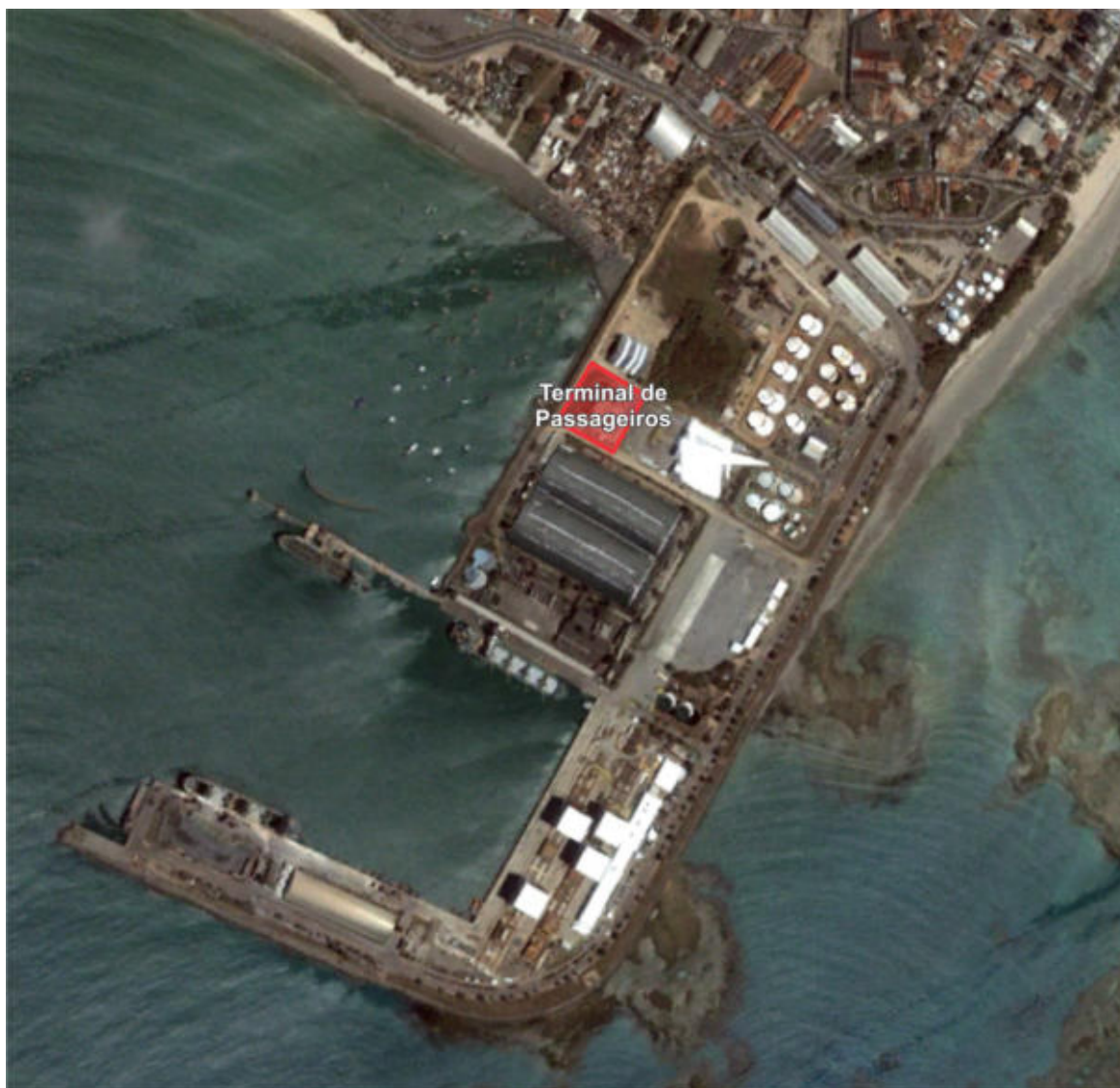
Figura 89. Localização do Futuro Terminal de Passageiros
