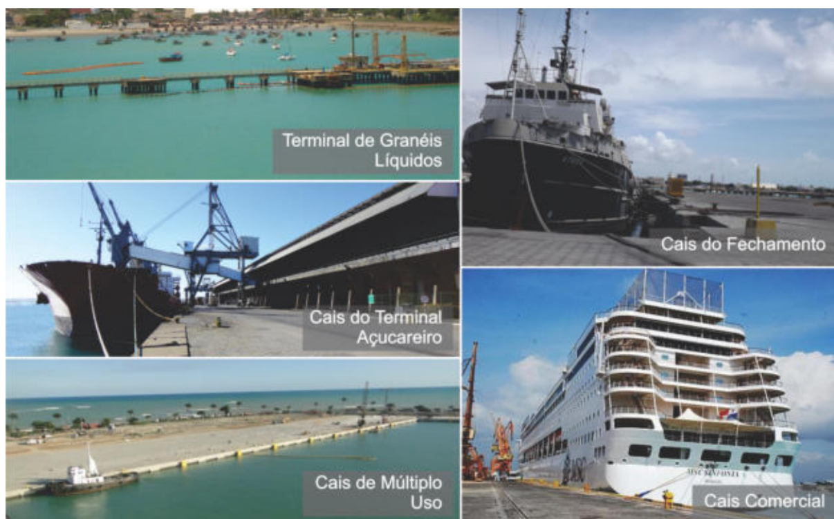
Figura 56. Trechos de Cais do Porto de Maceió
