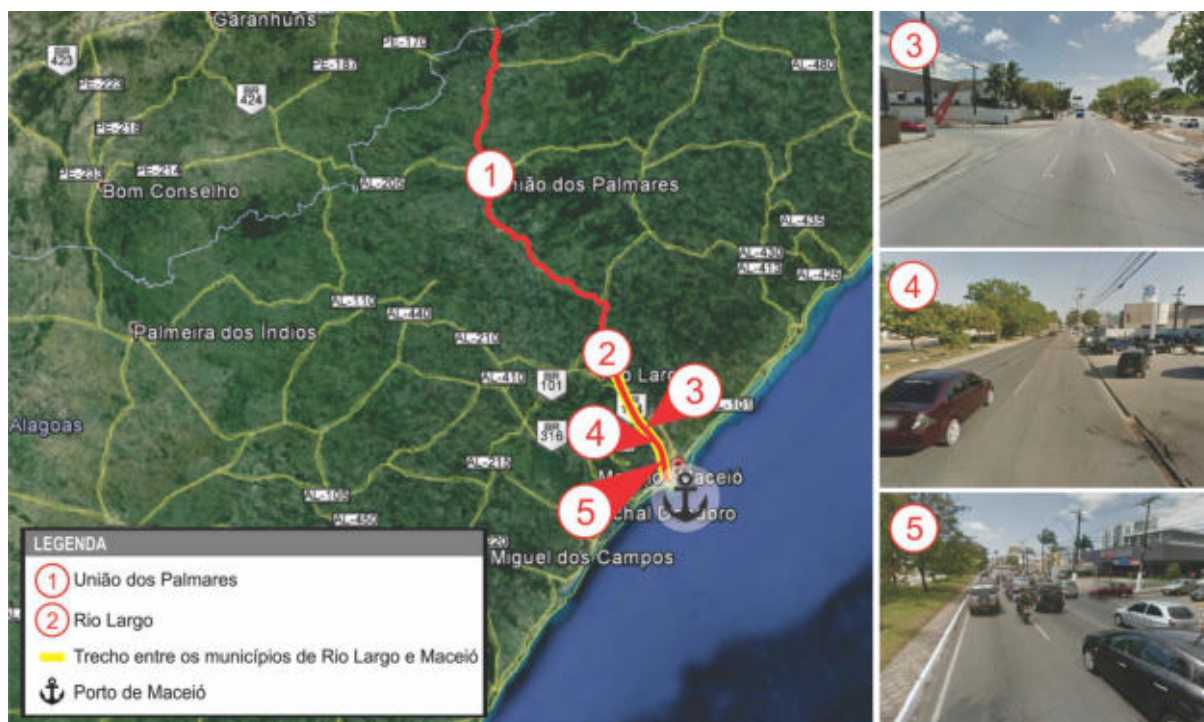
Figura 15. Pontos Críticos BR-104-AL
