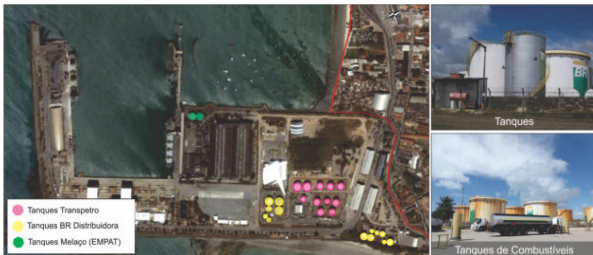
Figura 7. Tanques do Porto de Maceió
