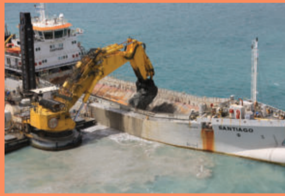
Figura 3: Draga mecânica retroescavadeira
