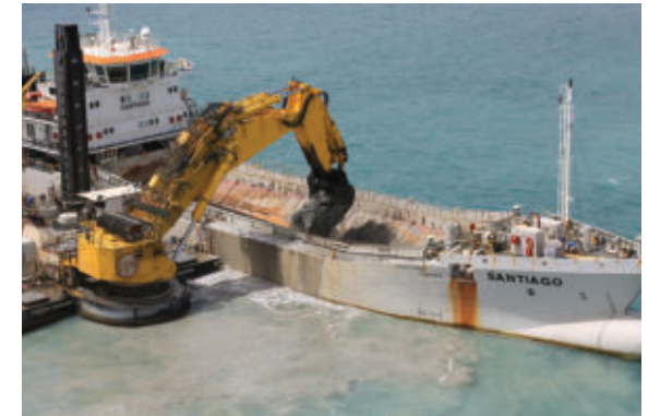
Figura 3: Draga mecânica retroescavadeira
