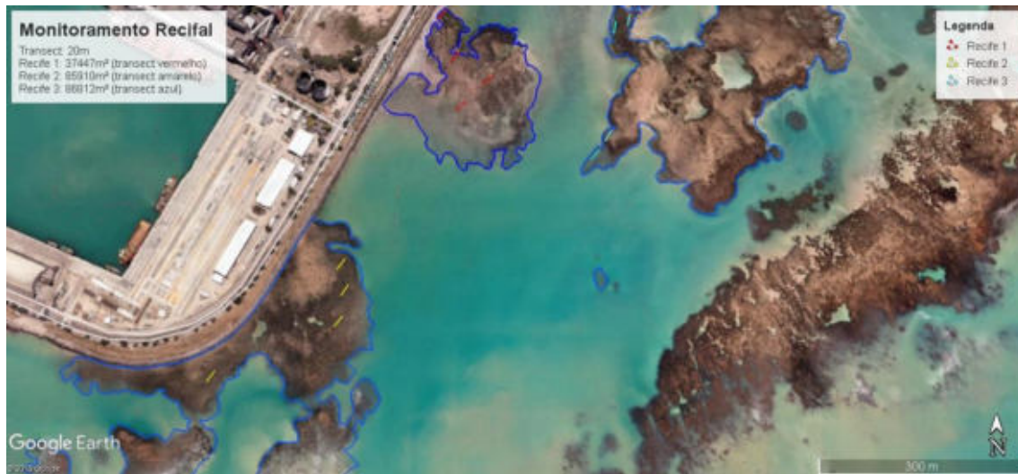
Figura 4 – Vista geral da área de trabalho.
